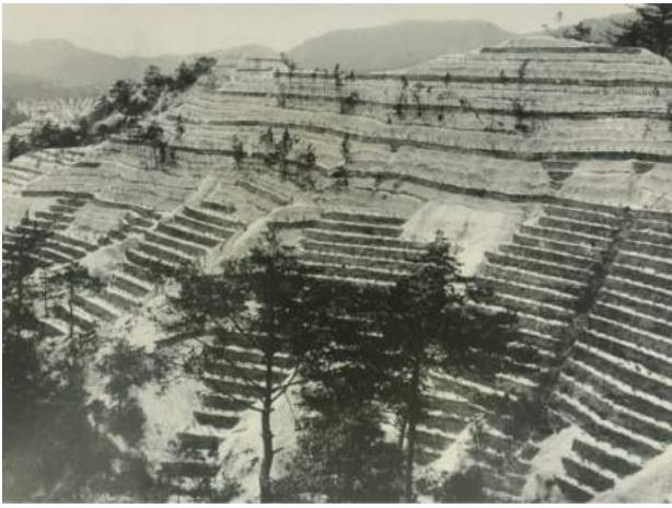
図-2 古代の都造営のため伐採されはげ山になった田上山（滋賀県大津市）。1914年の治山事業の様子。林野庁ホームページ「明治期の治山事業について」より。
